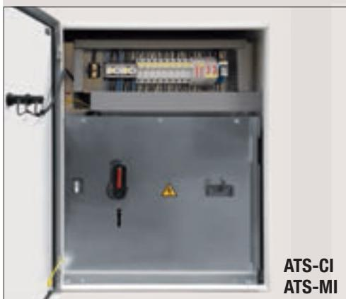
**CI** = Teleruttori, con relè voltmetrico rilevamento rete
