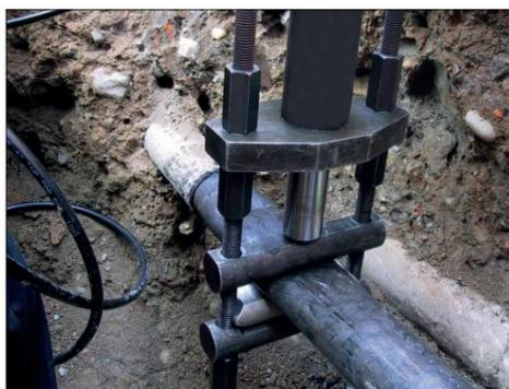
El grupo cilindro/travesaño se puede separar de la abrazadera para dejarlo en modo comprimido, la operación de compresión se puede repetir en otro punto del tubo con otra abrazadera.
