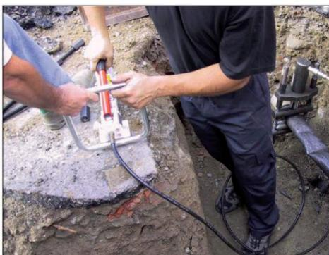
Operación de bombeo para compresión de tubería
